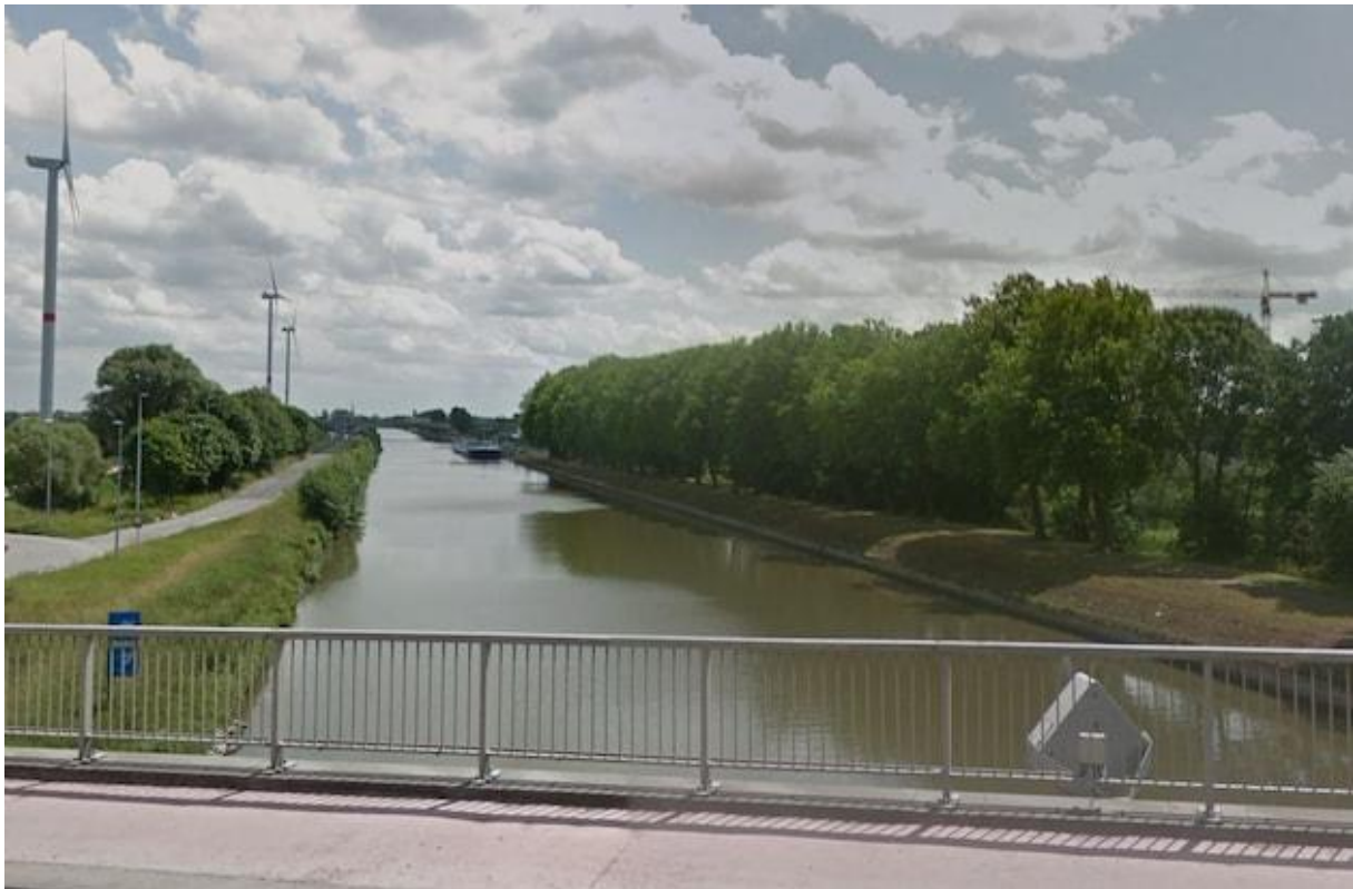
Het kanaal Roeselare-Leie ter hoogte van het bedrijventerrein. © Google Street View
