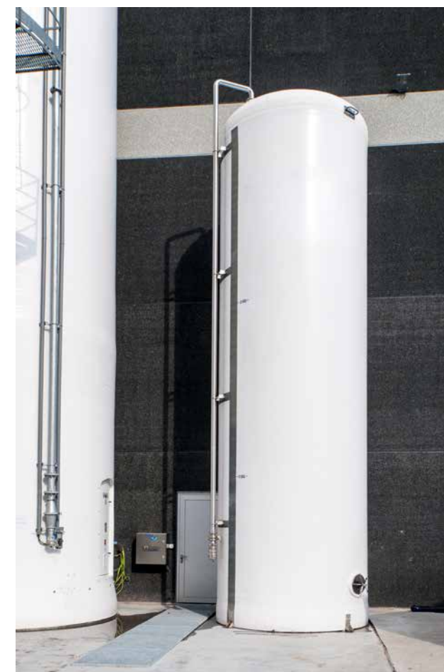
De pekkel wordt rechtstreeks geleverd en opgeslagen in een pekeltank, klaar voor gebruik in het productieproces.
